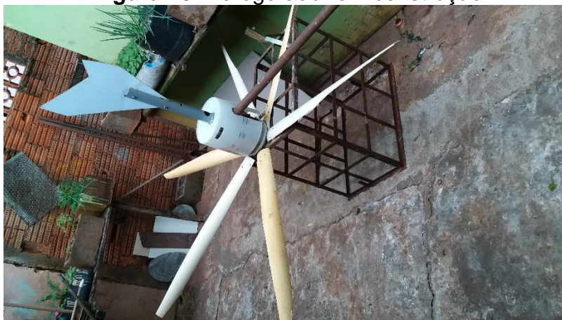
Figura 10: Aerogerador em construção
