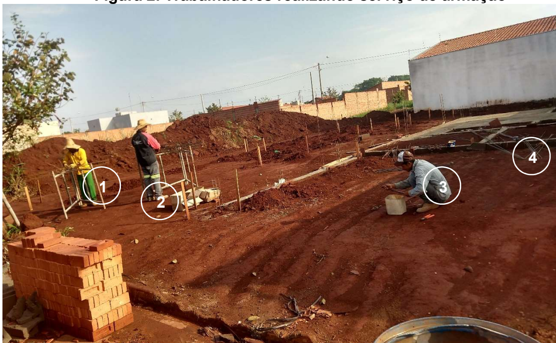
Figura 2. Trabalhadores realizando serviço de armação
