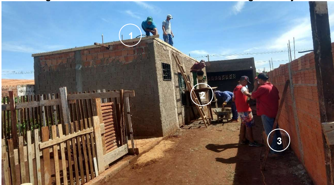
Figura 5. Trabalhadores executando a concretagem da laje
