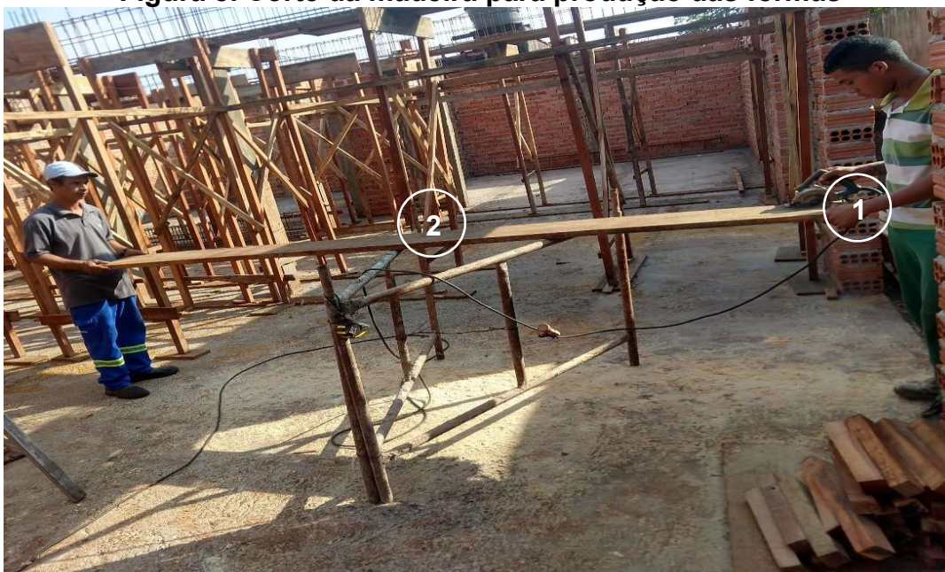
Figura 8. Corte da madeira para produção das fôrmas
