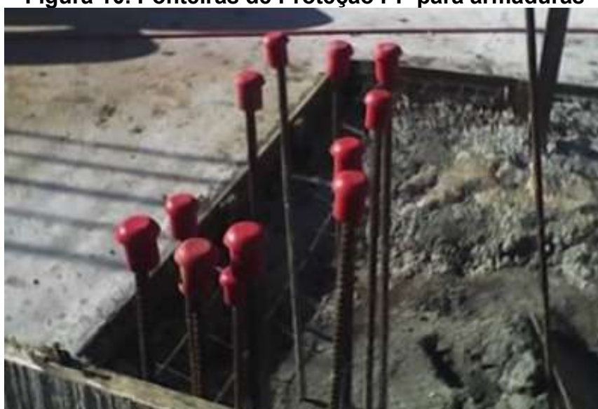
Figura 10. Ponteiros de Proteção PP para armaduras
