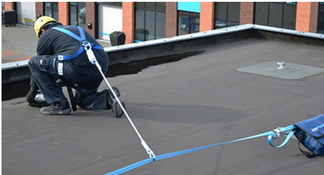
FIGURA 9. Modelo de linha de vida ancorado no talabarte e no cinto de segurança.
