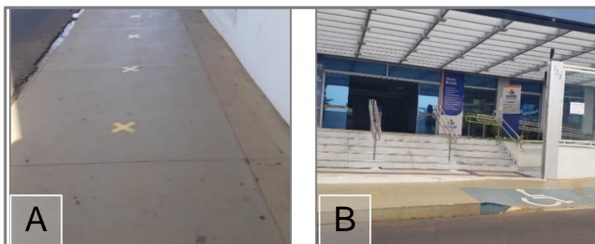
FIGURA 7 – Exemplo de trecho acessível identificado na área de estudo: Piso regular, construído em concreto (material firme e antiderrapante), sem obstruções (A), Rebaixamento de calçada para passagem de PcD (B)
