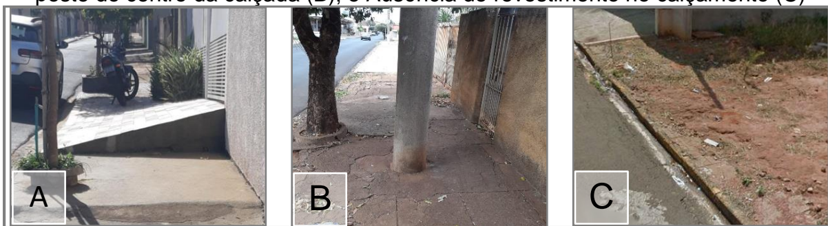
FIGURA 4 – Exemplos de situações que contribuíram para a diminuição da acessibilidade na área de estudo: Inclinação transversal elevada devido a ajuste para acesso de veículos (A); Limitação da faixa de circulação devido à instalação de poste do centro da calçada (B); e Ausência de revestimento no calçamento (C)
