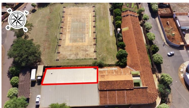
Figura 4 – Telhados da APAE
